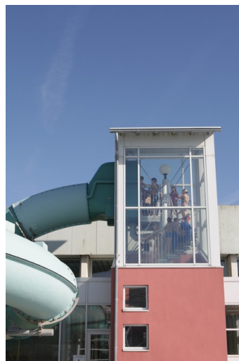
Abbildung 1 Rutsche im Ahoi Bad
